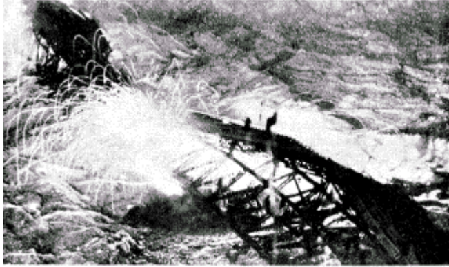
A híd roncsainak felrobbantása
